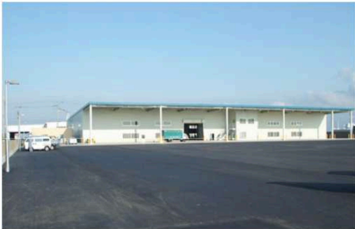
▲大分営業所 倉庫外観
