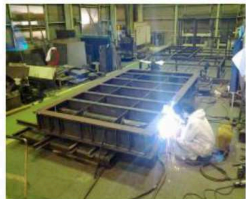
▲ 周辺機器等の製缶作業
