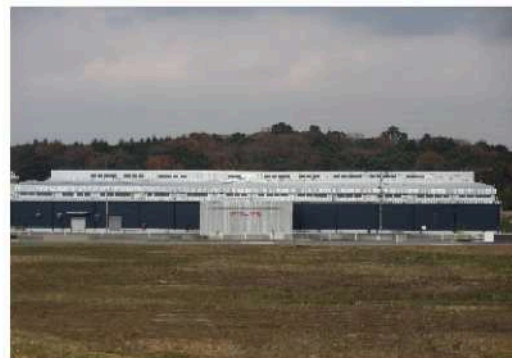
▲山宗(株)大分工場 2期工事完了 2016年12月
