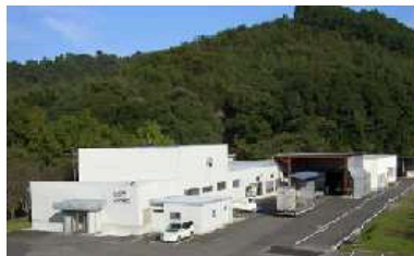
▲本社工場(敷地19,000㎡,工場1,800㎡)
