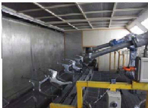
▲ 塗装ライン(フローコンベヤー)
