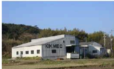
▲マシンセンター(敷地1,000㎡,工場600㎡)
