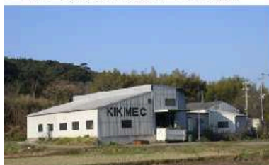
▲マシンセンター(敷地1,000㎡,工場600㎡)
