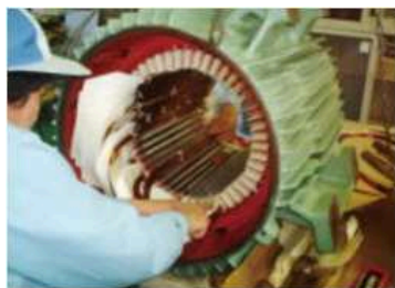
発電機・モーター点検・整備
