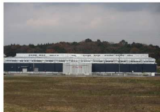
▲山宗(株)大分工場 2期工事完了 2016年12月
