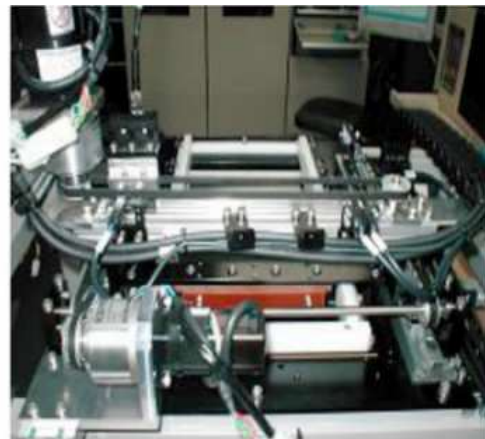
▲ メカ・ユニット組立/配線
